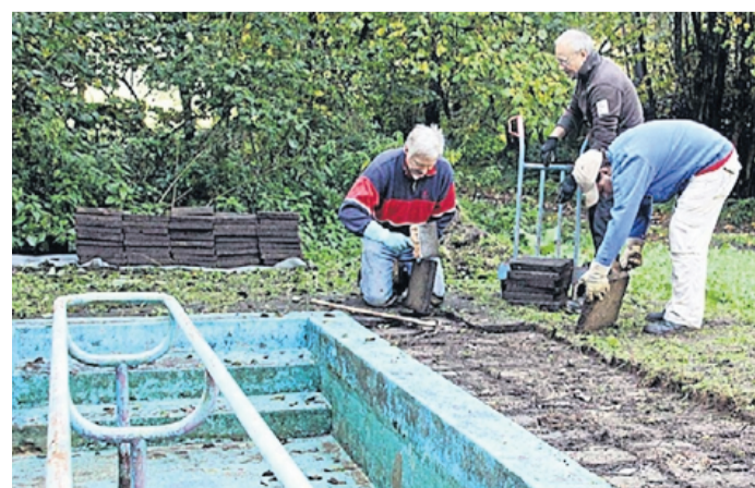
Die Helfer bringen Platten rund um das Tretbecken an. Anschließend soll das Becken hergerichtet werden. Foto: Sascha Valentin
